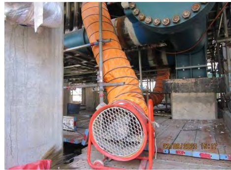
ภาพที่ 2.2-35 เครื่องระบายอากาศ บริเวณพื้นที่อับอากาศ
