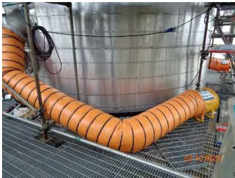
ภาพที่ 2.2-35 เครื่องระบายอากาศ บริเวณพื้นที่อับอากาศ
